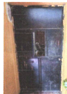
Foto 4: PUERTAS Mantenimiento a puerta metálica existente retiro de óxido, suciedad y pintura deteriorada; incluye cepillado, lijado y aplicación de pintura. En bodega
