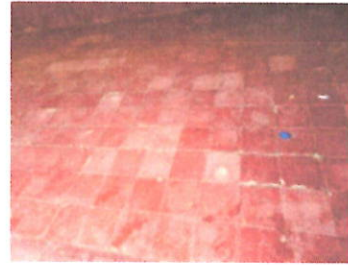
Foto 2: PISO Sustitución de piso de concreto con acabado liso por piso de granito, incluyendo preparación de superficie y nivelación. Aula 1 y aula 2
