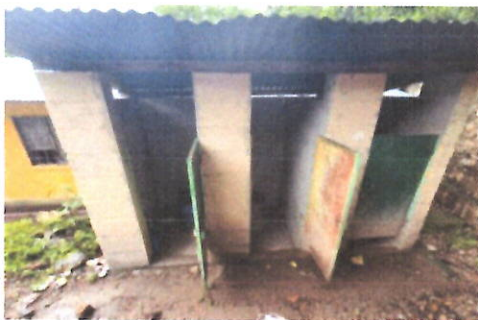
Foto 3: PUERTAS Suministro e instalación de puerta metálica, incluyendo chapa, bisagras. En baños
