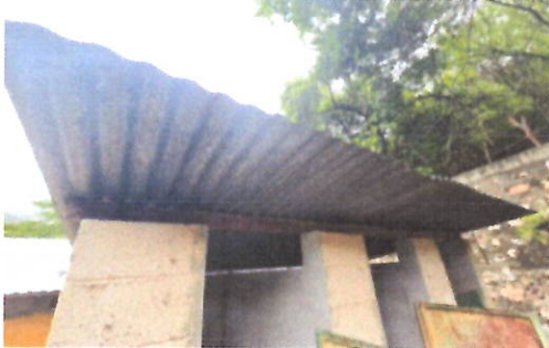
Foto 1: CUBIERTA DE LAMINA Sustitución de cubierta de techo con lámina galvanizada, Tipo de lamina: troquelada Calibre: 26, incluye: fijaciones y sellado en traslapes. Baños
