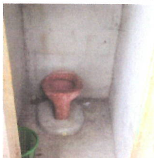
Foto 3: PISO Sustitución de piso de concreto con acabado liso por piso cerámicos antideslizante, incluyendo preparación de superficie y nivelación. Baños
