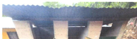
Foto 6: ESTRUCTURA DE TECHO Sustitución de estructura de madera para soporte de cubierta de lámina incluyendo perfiles para vigas, travesaños, sujeta con tornillería; corte, soldadura y anclaje de la estructura portante. Baños
