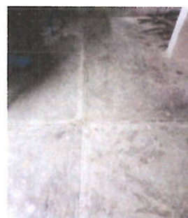
Foto 6: PISO Sustitución de piso de concreto con acabado liso por piso cerámico, incluyendo preparación de superficie y nivelación. Cocina
