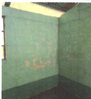
Foto 1: PINTURA EN MUROS INTERIOR Y EXTERIOR Preparación de la superficie y aplicación de pintura a dos manos, en paredes interiores y exteriores del establecimiento, cocina y baños.
